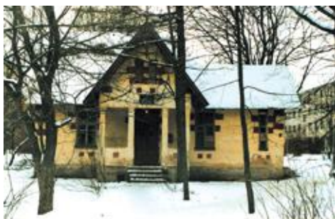
Былы адміністрацыйны будынак Лужаснянскай земляробчай школы
